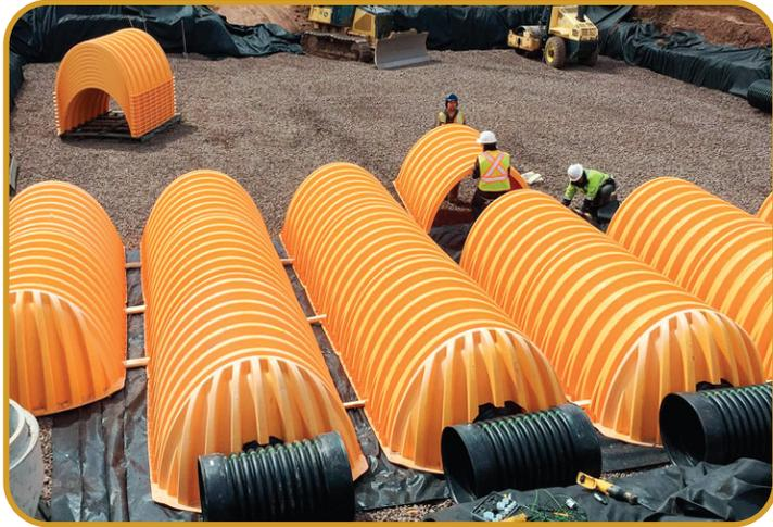
Los sistemas **ADS StormTech** son la solución ideal para controlar el flujo pluvial extraordinario en zonas urbanas, aísla los sedimentos y contaminantes de los primeros escurrimientos y permite la recarga de acuíferos a través de la infiltración del agua pluvial.
